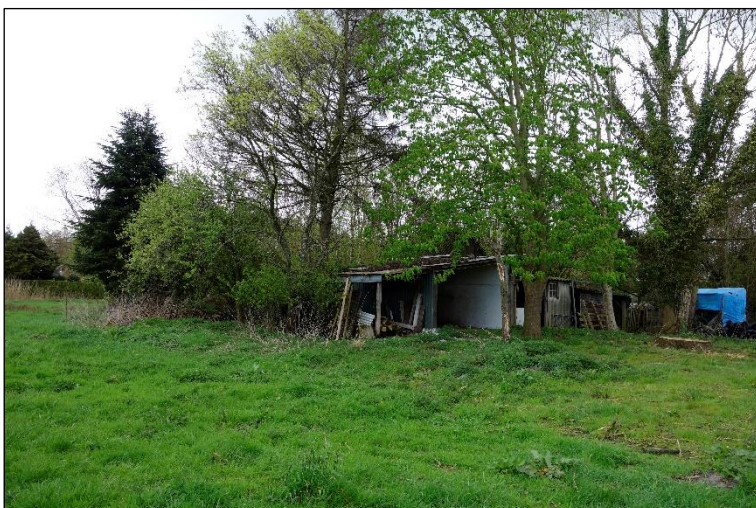
Abbildung 2: Im Umfeld des im Verfall befindlichen Gebäudes im Osten des Plangebietes stehen mehrere Einzelbäume (25.04.2023).
